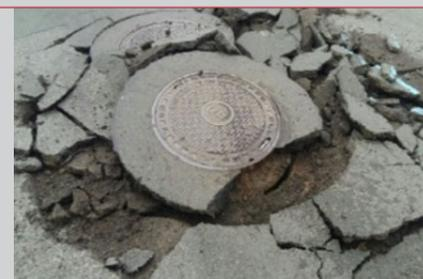
检修井电缆劣化导致道路损坏
