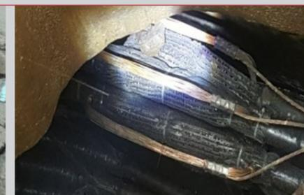
本产品施工电缆周围损坏最小化
